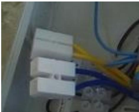
Je dois donc à priori relier un spot à ces 2 fils jaunes et l'autre spot aux 2 fils bleus (ces fils vont sur bobinage...le bobinage sert sûrement à abaisser le courant secteur à 12V)
