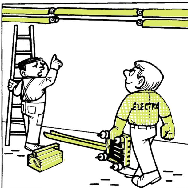
Pour être efficace, l'isolation temporaire des conducteurs doit être réalisée avec soin.
