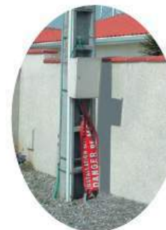
Réseau aérien : Coffret sur poteau (Cas du terrain non viabilisé)
